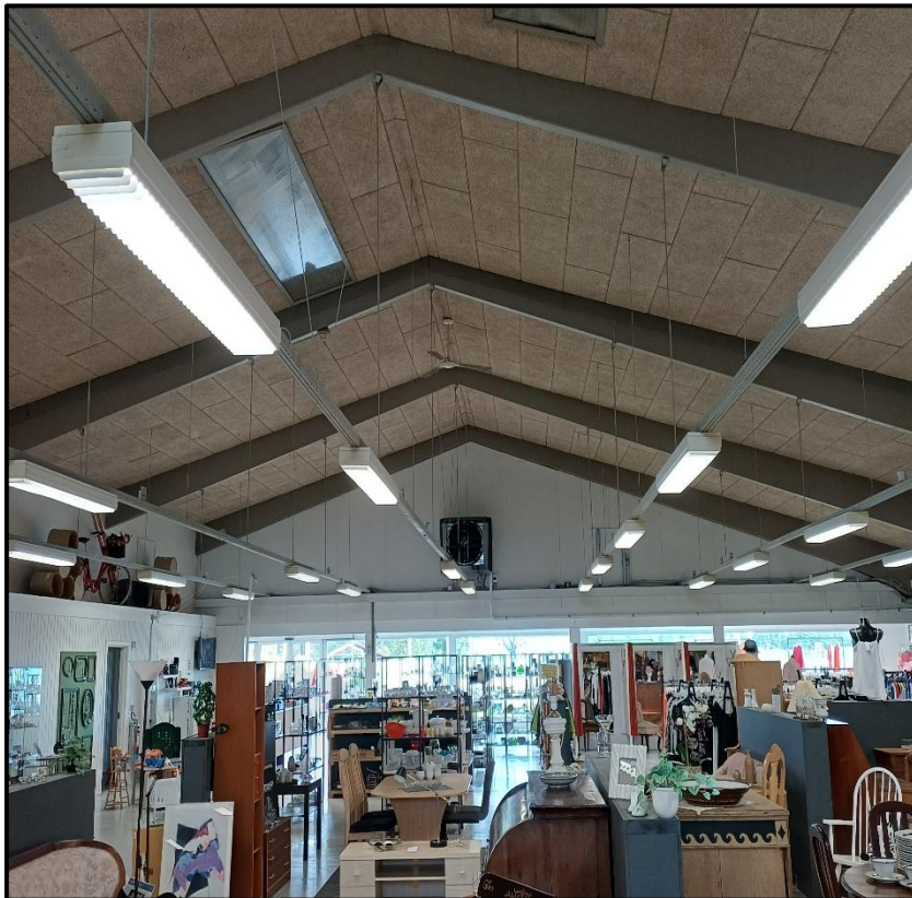
Figur 4.1: Bygning 1. Foto: DMR A/S.
