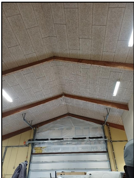
Figur 4.2: Bygning 2. Foto: DMR A/S.
