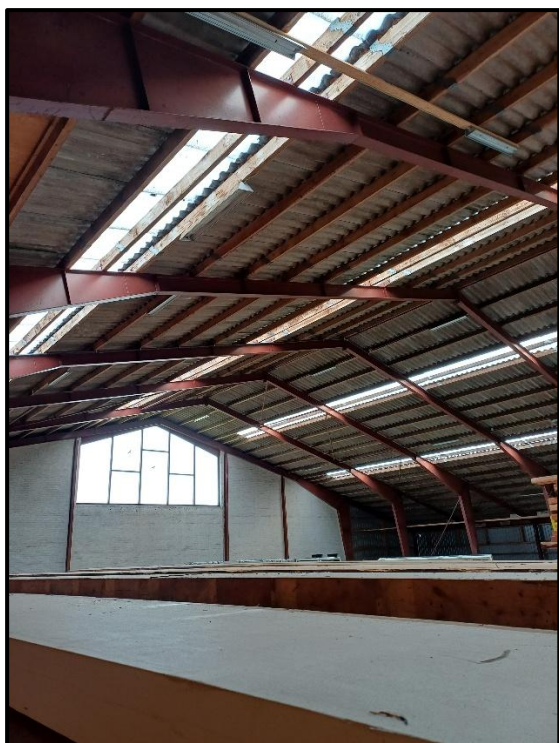
Figur 4.3: Bygning 3. Foto: DMR A/S.
