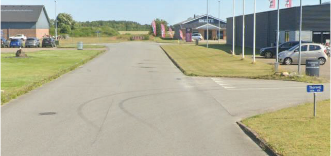
Figur 6. Thorsvej nord for rundkørsel med Vejle Landevej, set mod nord
